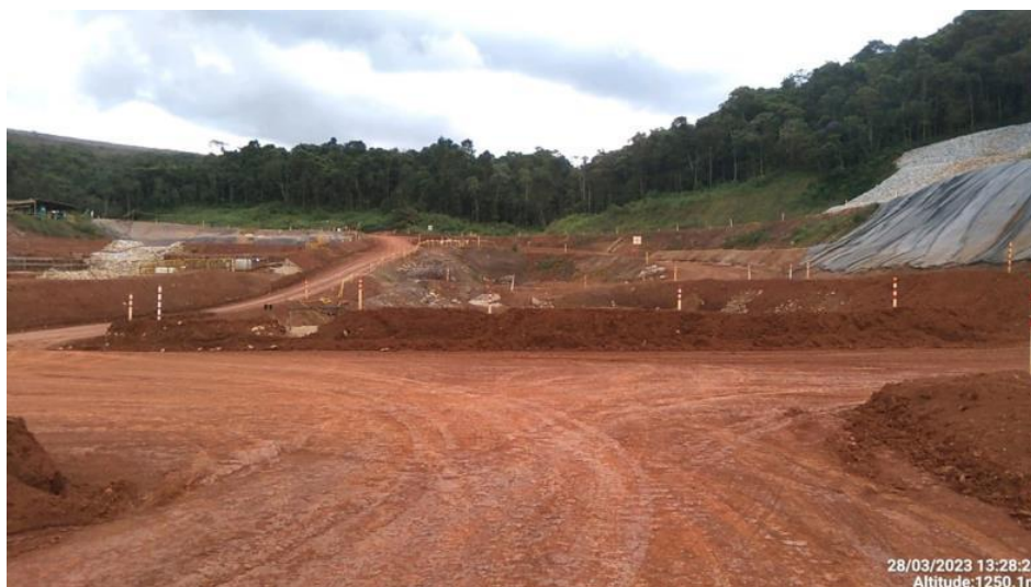
Foto 23 Vista das mantas de Bidim implantadas na área do extravasor, na margem esquerda Autor: VALE, 2023
