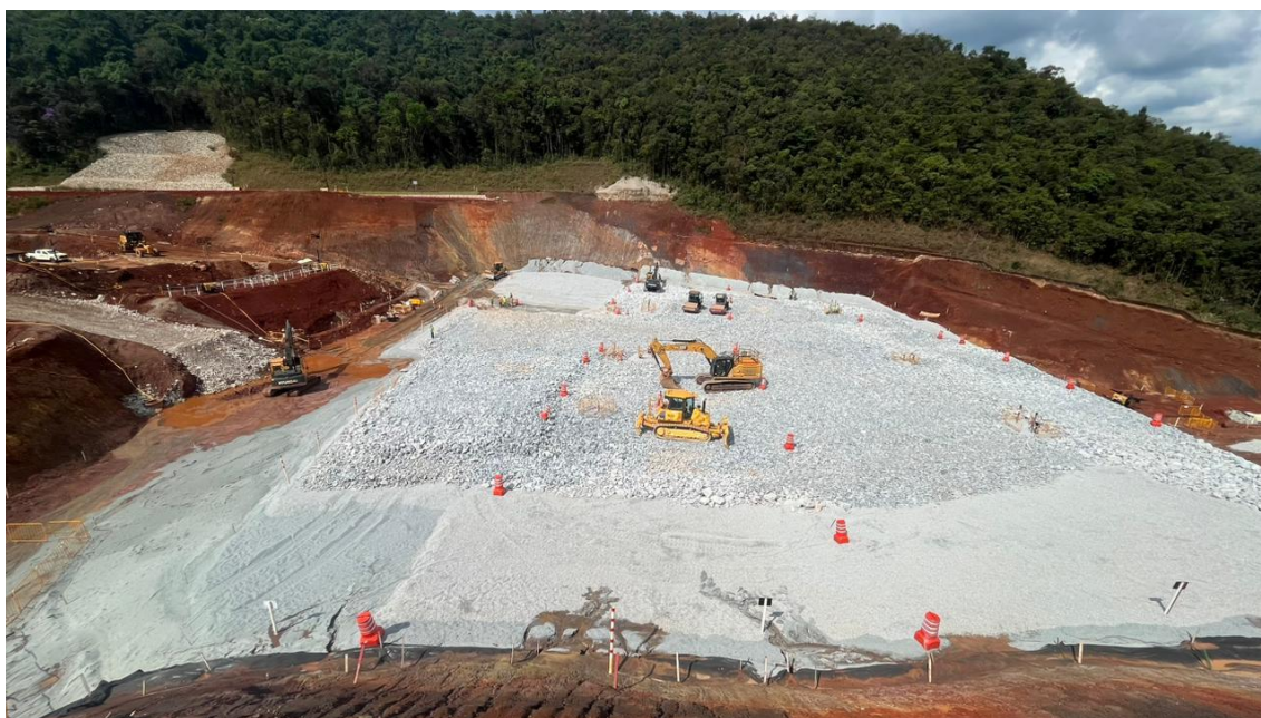
Foto 10 Enrocamento: compactação de material observado em outubro de 2023
