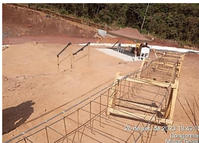
Foto 11 Drenagem Superficial: início da execução de armação e forma do Canal CP02 realizado em setembro de 2023.
