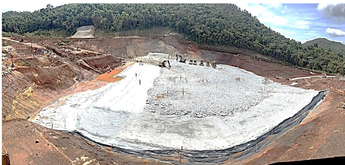
Foto 09 Tapete drenante: vista geral da atividade finalizada em setembro de 2023.
