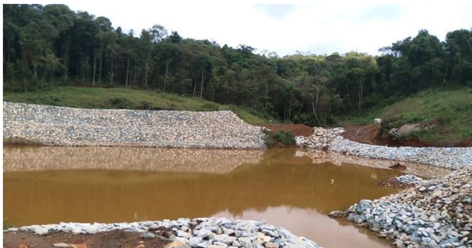
Foto 22 Sump a montante com três filtros de enrocamento. Autor: VALE, 2023
