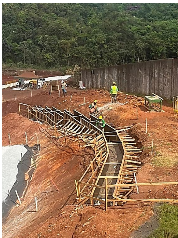
Foto 12 Drenagem Superficial: continuidade da execução de armação e forma do Canal CP02 realizado em outubro 2023.
