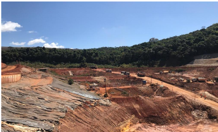
Foto 24 Reconformação dos taludes na margem direita e margem esquerda.
